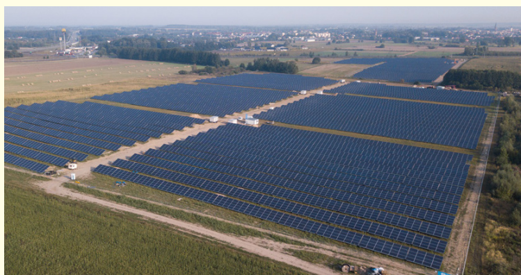
Sulechów (Panele fotowoltaiczne ustawione szeregowo na ziemi)
